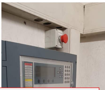
Locale tecnico (PT), vano scale portineria 2
